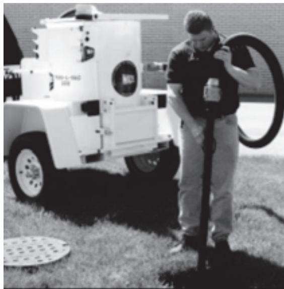
Figura 3-6. Use el tubo de aspiración para extraer el agua y los residuos de la caja de la válvula.
